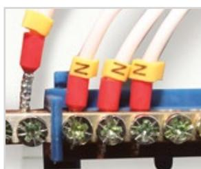
Зачищенный конец многожильного провода заводится внутрь полой концевой трубки и затем опрессовывается вместе с ней при помощи специального инструмента – обжимных клещей КО. Таким образом, возникает единая конструкция, надёжно фиксирующая пучок многопроволочной жилы.
